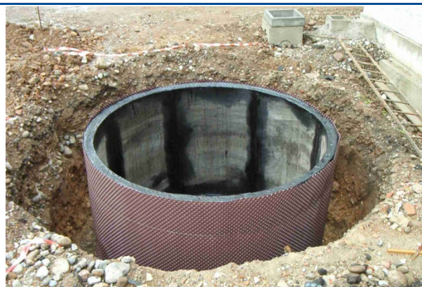
Figura 5.3 Dettaglio vasca stagna raccolta percolato pressa
