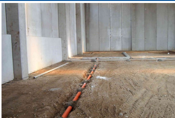
Figura 5.2 Dettaglio griglia pressa + canalizzazione alla vasca stagna
