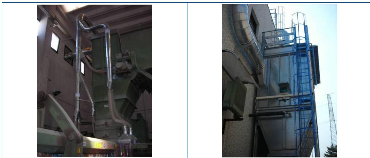
Figura 5.1 Impianto di abbattimento ed aspirazioni polveri
