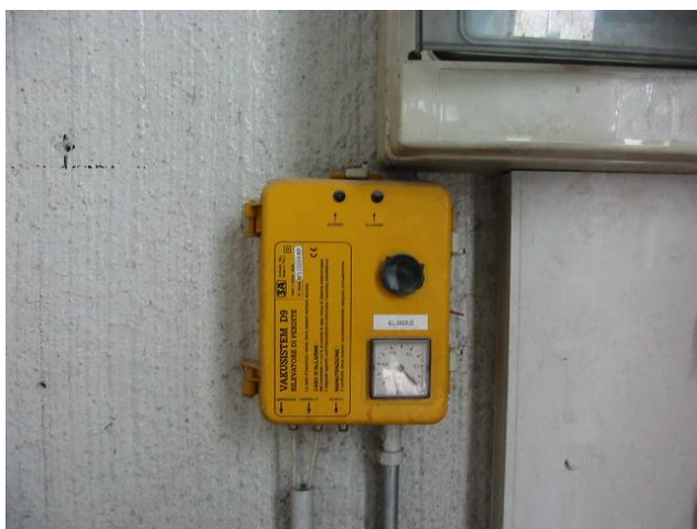
Figura 5.4 Sistema monitoraggio tenuta e allarme
