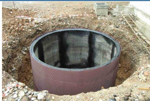
Figura 5.3 Dettaglio vasca stagna raccolta percolato pressa
