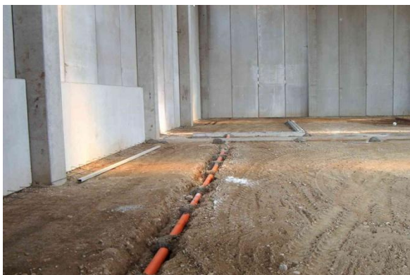
Figura 5.2 Dettaglio griglia pressa + canalizzazione alla vasca stagna
